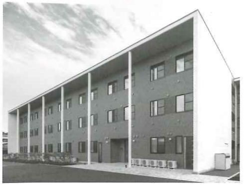
2015年10月に新規開設した特定施設入居者生活介護の指定を受けているサービス付き高齢者向け住宅「ライブラリ淵野辺」(神奈川県・相模原市)。
